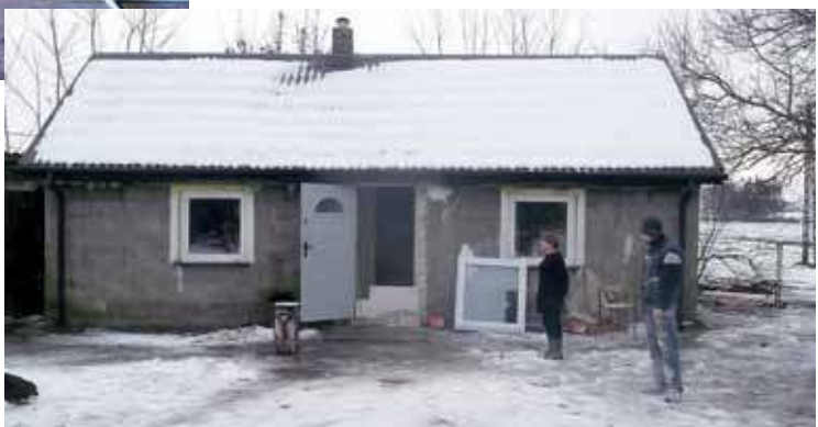
Ten dom po odbudowie
