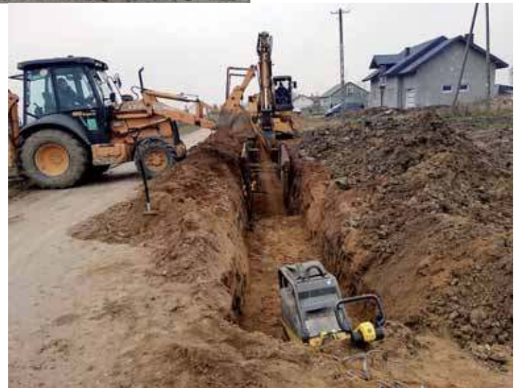
Budowa kanalizacji w Karwaczu
