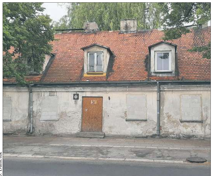
Przy ul. Sienkiewicza 44 stanie nowy budynek
