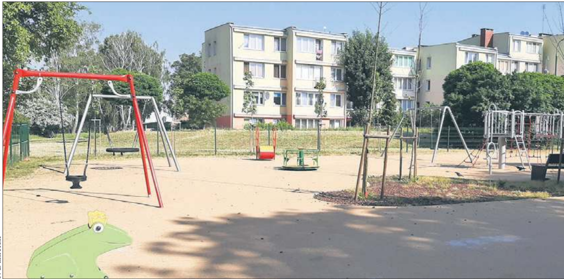
Realizacja pierwszego etapu budowy Centralnego Parku Rekreacji zakończyła się jesienią 2019 roku
