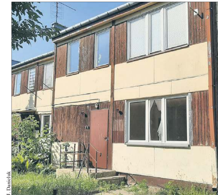
Budynek przy ul. Miodowej 29 wkrótce zostanie wyburzony. Zastąpi go nowy blok
