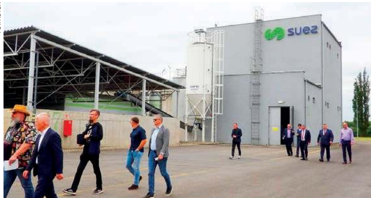
Miejska oczyszczalnia ścieków w Mławie
