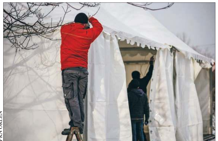
Montaż ogrzewanych namiotów
