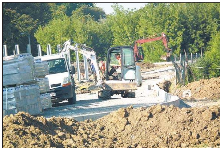
Od ul. Rzeczej widać już jak wyglądać będzie nowa droga.
