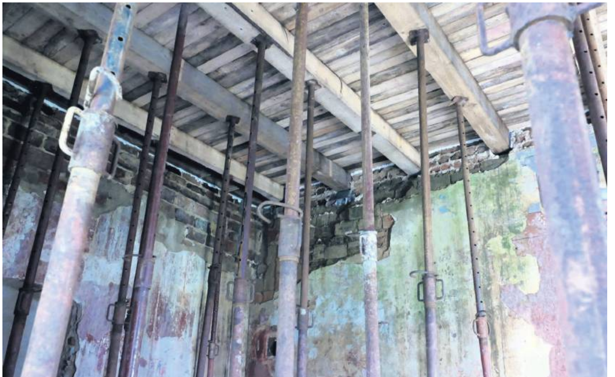
W tylnym traktie budynku wykonano stropy żelbetowe
