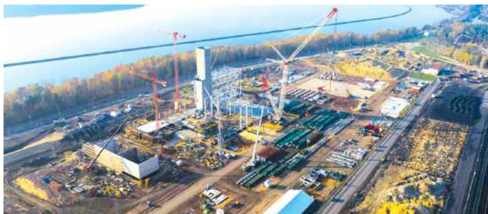
Nowo budowany blok gazowo-parowy w Rybniku
