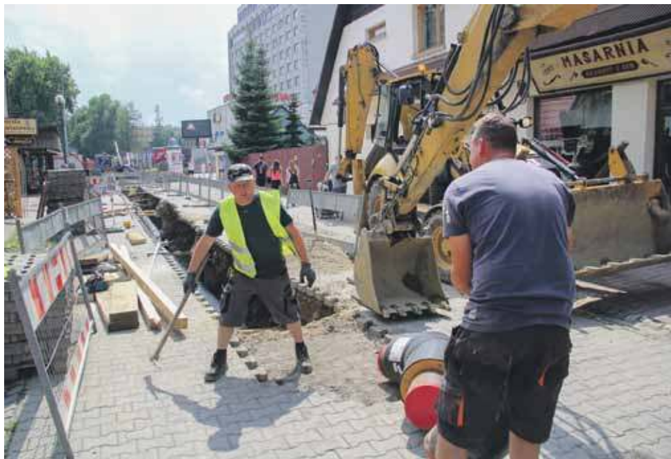
Trwa układanie rur ciepłowniczych w ul. Krzywej.
