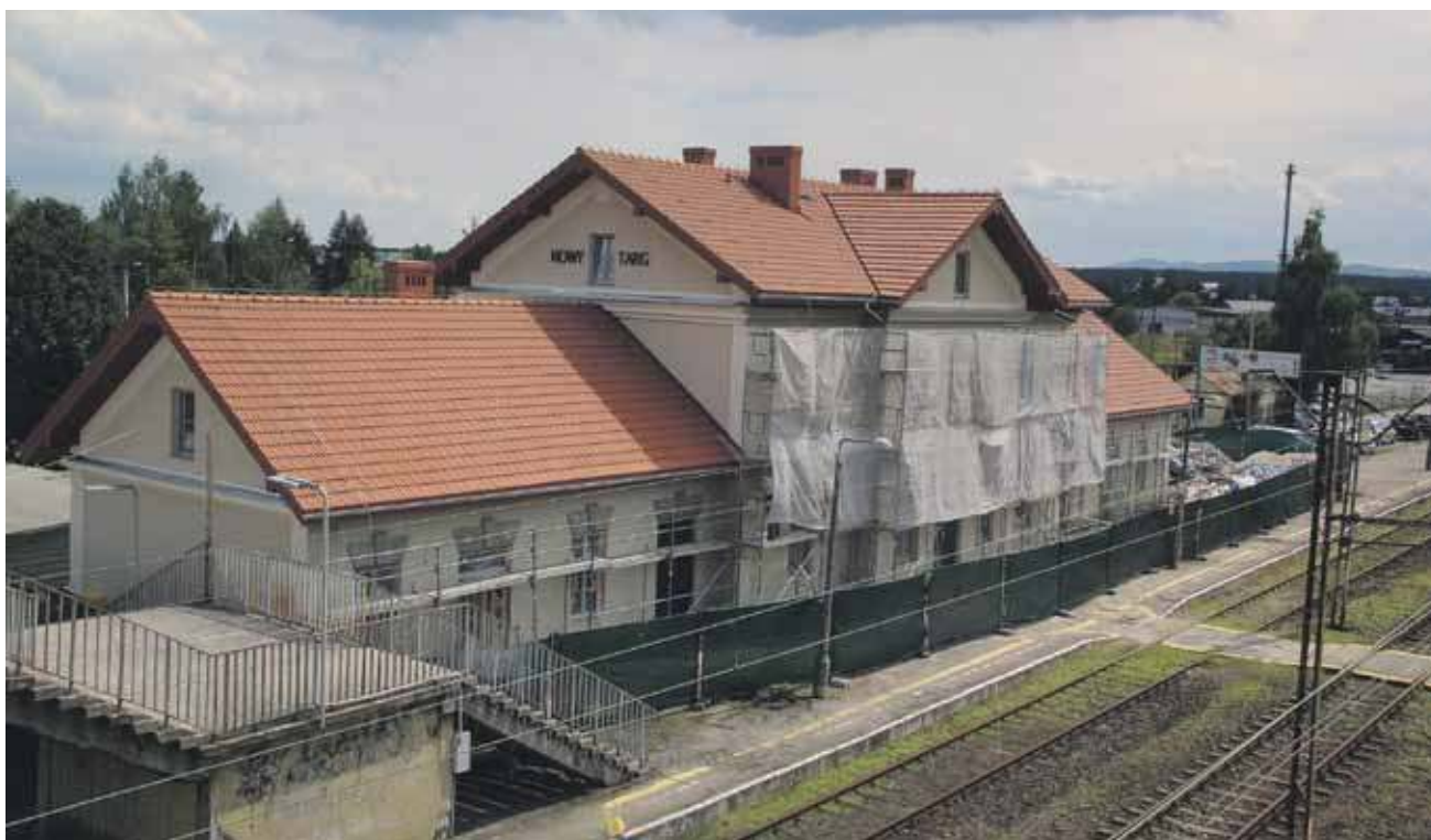
Na zewnątrz dworca kolejowego trwają ostatnie prace wykończeniowe.
