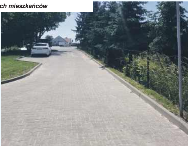
Nowa droga dojazdowa do przedszkola w Krynicznie
