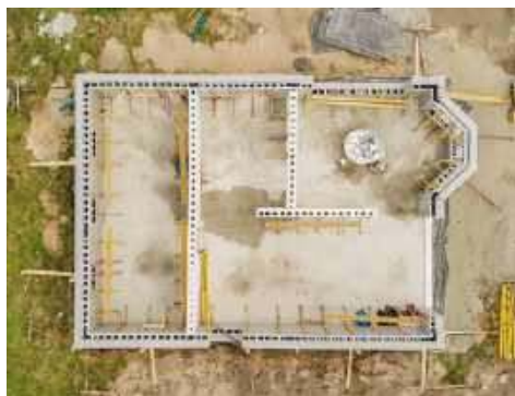
U Ściany z kształtek styropianowych buduje się bardzo szybko, a ich parametry termiczne są często znacznie lepsze niż w technologiach tradycyjnych. IZODOM 2000 POLSKA
