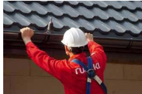
🔧 Montaż orynnowania należy powierzyć dekarzom, którzy mają odpowiedni sprzęt oraz doświadczenie w pracy na wysokości. RUUKKI
