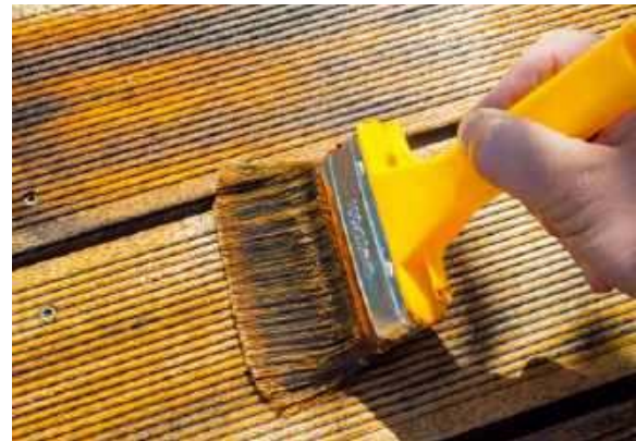
📌 Do mycia całego tarasu najlepiej użyć myjki ciśnieniowej (a KÄRCHER). Miejscowe zabrudzenia w postaci plam można usunąć ręcznie szczotką (b JAF POLSKA).
