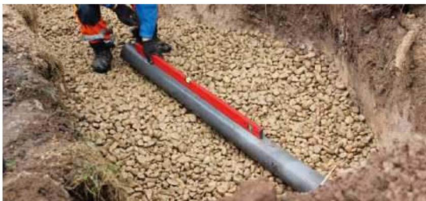
🔧 Rury drenarskie układa się w grubej warstwie kruszywa, ze spadkiem umożliwiającym grawitacyjny spływ ścieków. J. WERNER
