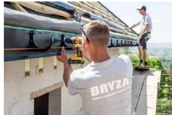
🔧 W nowych budynkach rynny montuje się przed ułożeniem pokrycia. CELL FAST
