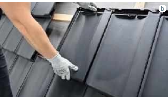
🔧 Układanie dachówek zaczyna się od rozlokowania ich na połaci (a). Następnie łączy się kolejne elementy (b). CREATON POLSKA
