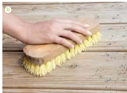
📌 Do mycia całego tarasu najlepiej użyć myjki ciśnieniowej (a KÄRCHER). Miejscowe zabrudzenia w postaci plam można usunąć ręcznie szczotką (b JAF POLSKA).
