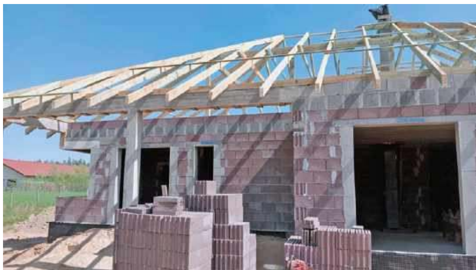
U Keramzytobeton to budulec porowaty i lekki, a jednocześnie wytrzymały. Wykonuje się z niego ściany dwuwarstwowe. CZAMANINEK
