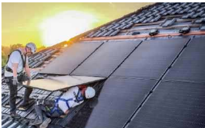
Podstawą systemu przeznaczonego na dach kryty dachówką jest podkonstrukcja oraz moduły (wykonane z tafli czarnego szkła, umieszczonej w czarnej, aluminiowej ramie), umożliwiające pełną integrację z połacią. CREATON POLSKA (VARIO)
