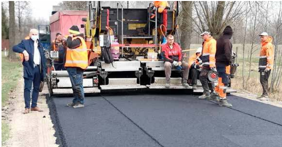
Wójt Waldemar Cyran (w maseczce) na budowie drogi Sadowne-Grabiny.
