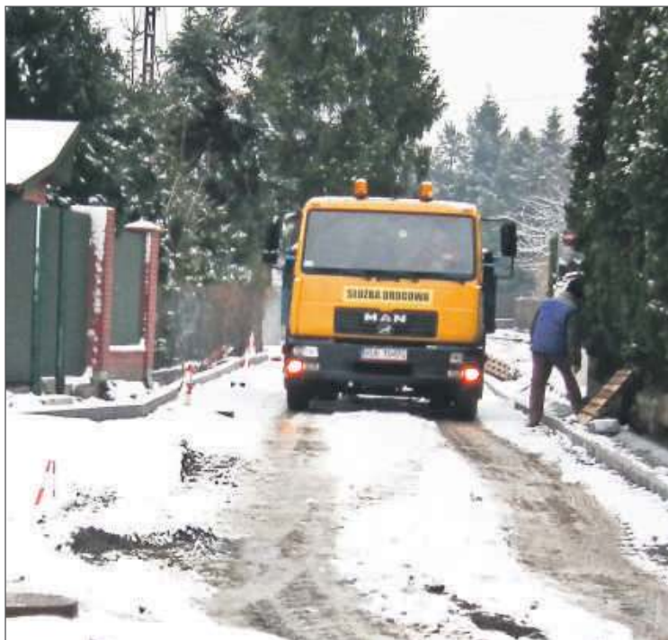
Przebudowa dróg łączyć się będzie z utrudnieniami w ruchu. fot. arch.
