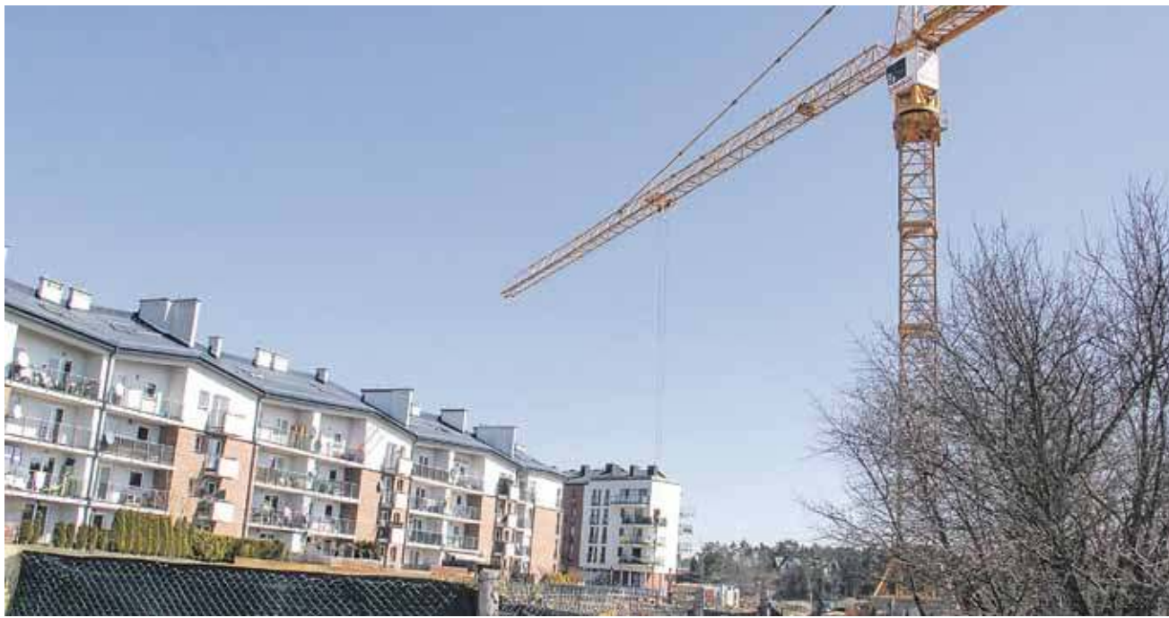
Ogrodzona działka Henryki Marciniak, na której stanął żuraw budowlany. Za płotem praca widać.
