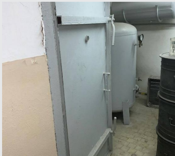
Fot. 3 Przykład istniejących stalowych drzwi ochronnych
