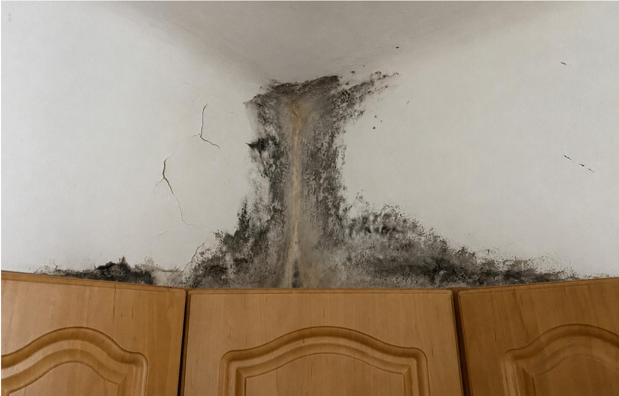
Fot. 1 Intensywne porażenie pleśnią w narożniku pomieszczenia
