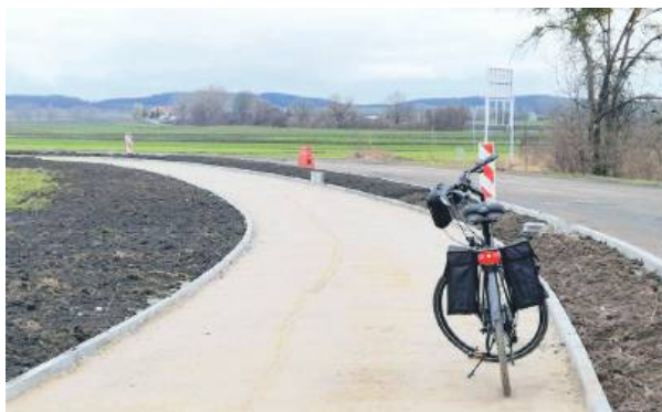
Kilka tygodni temu rozpoczęła się budowa ścieżki pieszo-rowerowej przy drodze Kondratowice – Prusy. Efekty prac widać gołym okiem. Fot. UG Kondratowice
