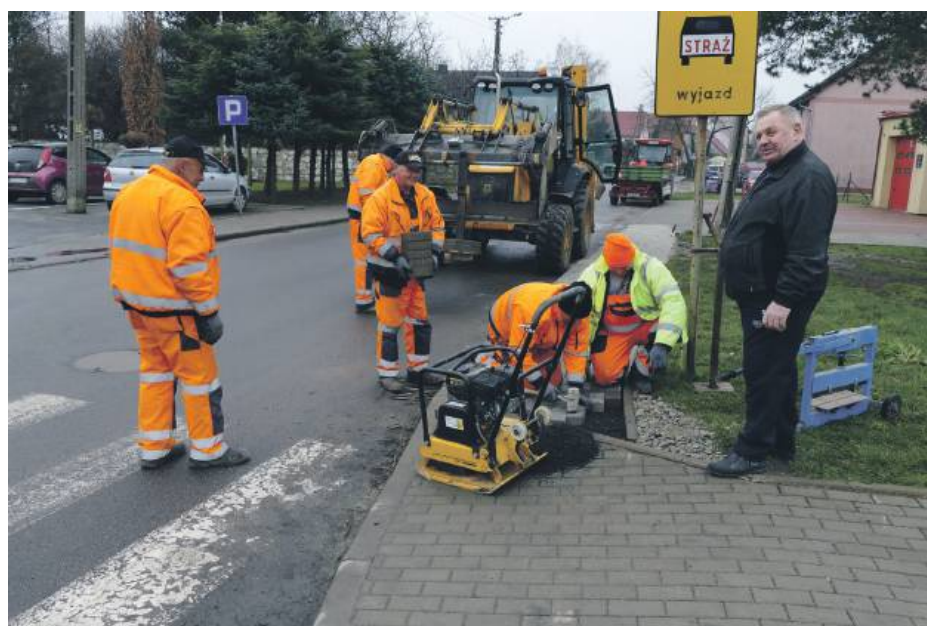
Pracownicy PZD ułożyli fragment chodnika od remizy do ul. Szkolnej w Przewornie
