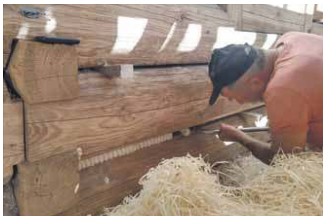
- Mech nie wytrzymałby stu lat. Zresztą on nasiąkał wilgocią, a od niego wilgotniały płazy. Wełnianka jest sucha, szybko się nagrzewa, oddaje ciepło płazom. Była porządnie zrobiona, skoro wytrzymała 100 lat - mówi Tadeusz Franos z Ratułowa, który właśnie wymienia starą wełniankę.
