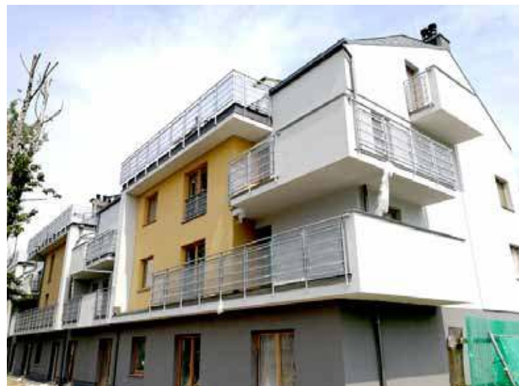
W budynku przy ul. Tańskiego powstały 34 mieszkania przeznaczone do zasiedlenia osobom uprawnionym do przydziału lokalu mieszkalnego
