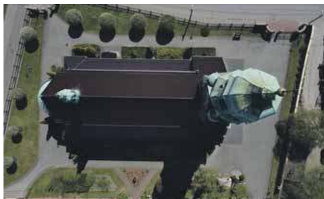
Trzynawowy kościół od strony wschodniej ma prezbiterium z dachem półokrągłym, namiotowym. Po obu stronach zlokalizowano zakrystie
