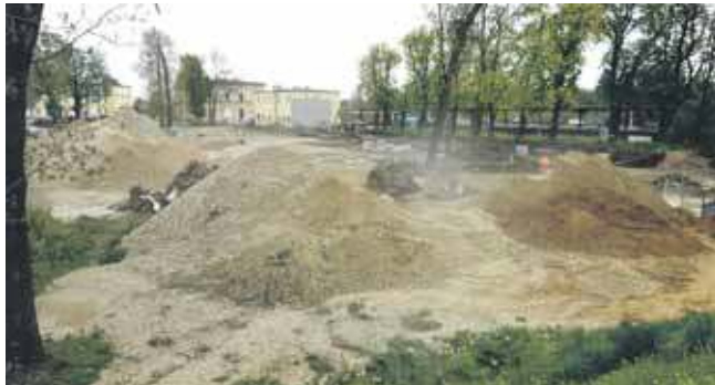
Centrum przesiadkowe w Tarnowskich Górach miało zostać oddane w marcu. Tak w poniedziałek wyglądał plac budowy
