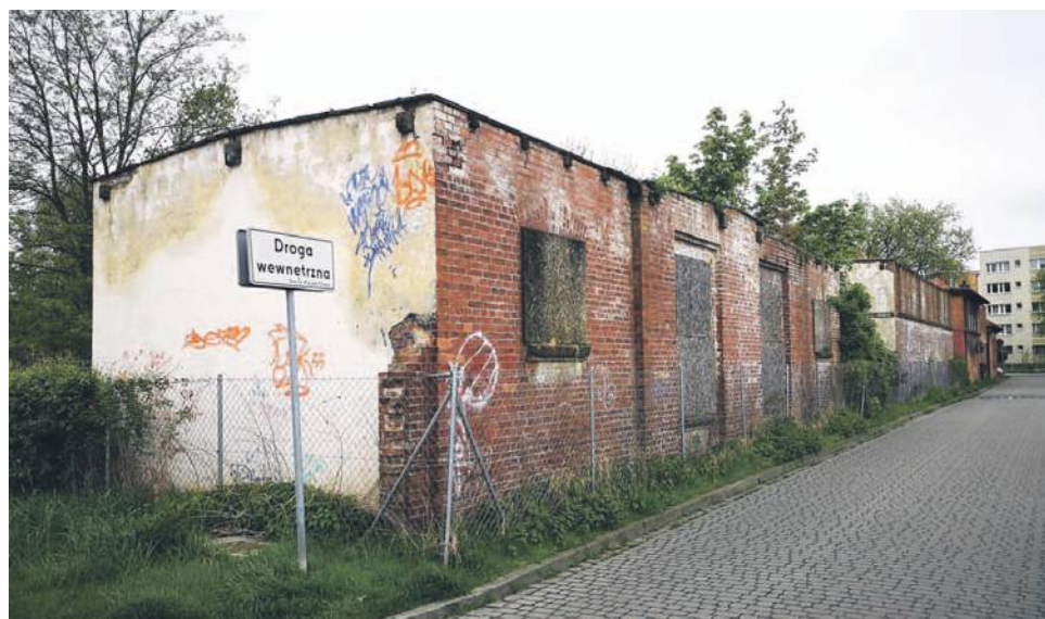
Dwa nieużytkowane i dotychczas niszczących budynki przy ulicy Magazynowej miasto zamierza przeznaczyć na mieszkania
