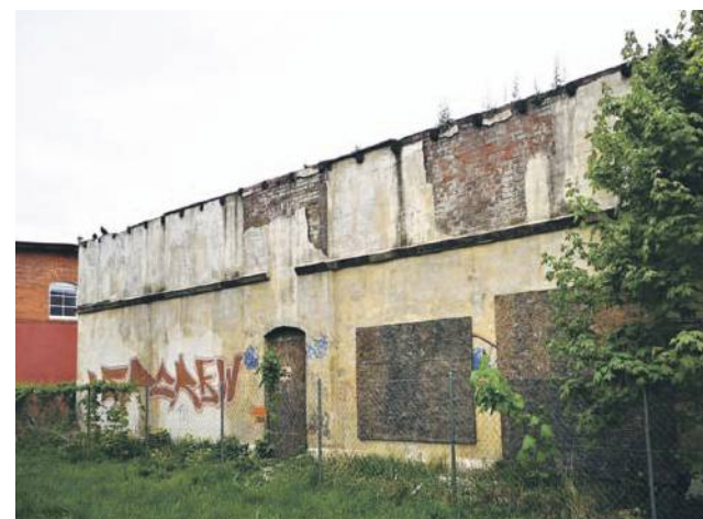
Inwestycja w tym miejscu zamknie teren tzw. starych koszar w zakresie remontu i rewitalizacji
