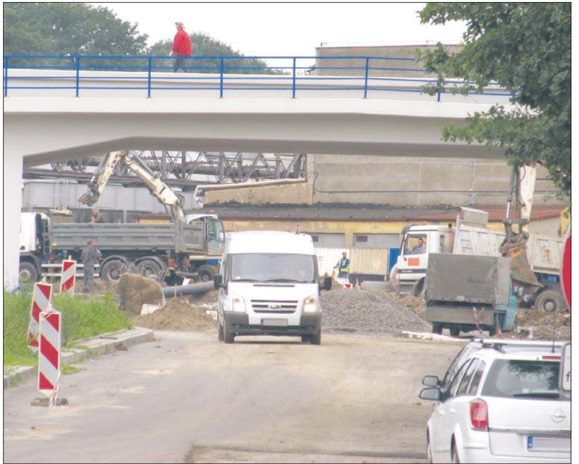
Przejazd pod wiaduktem na ul. 1 Maja w Dębicy ma zostać udostępniony kierowcom po 9 września.
