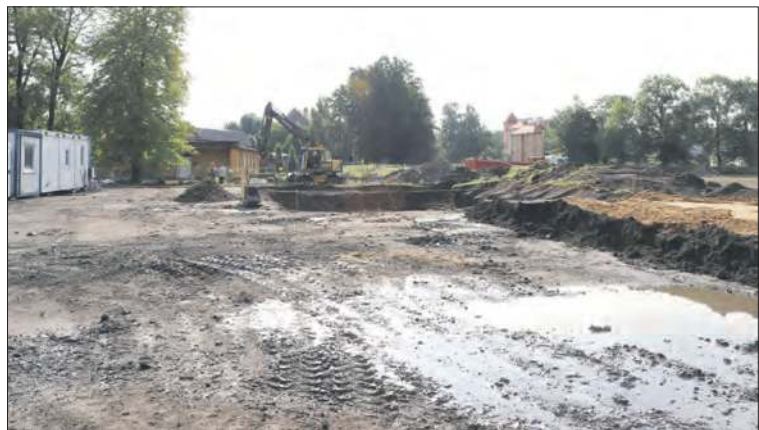
Trwa przebudowa stadionu przy ul. Kolejowej w Prudniku
