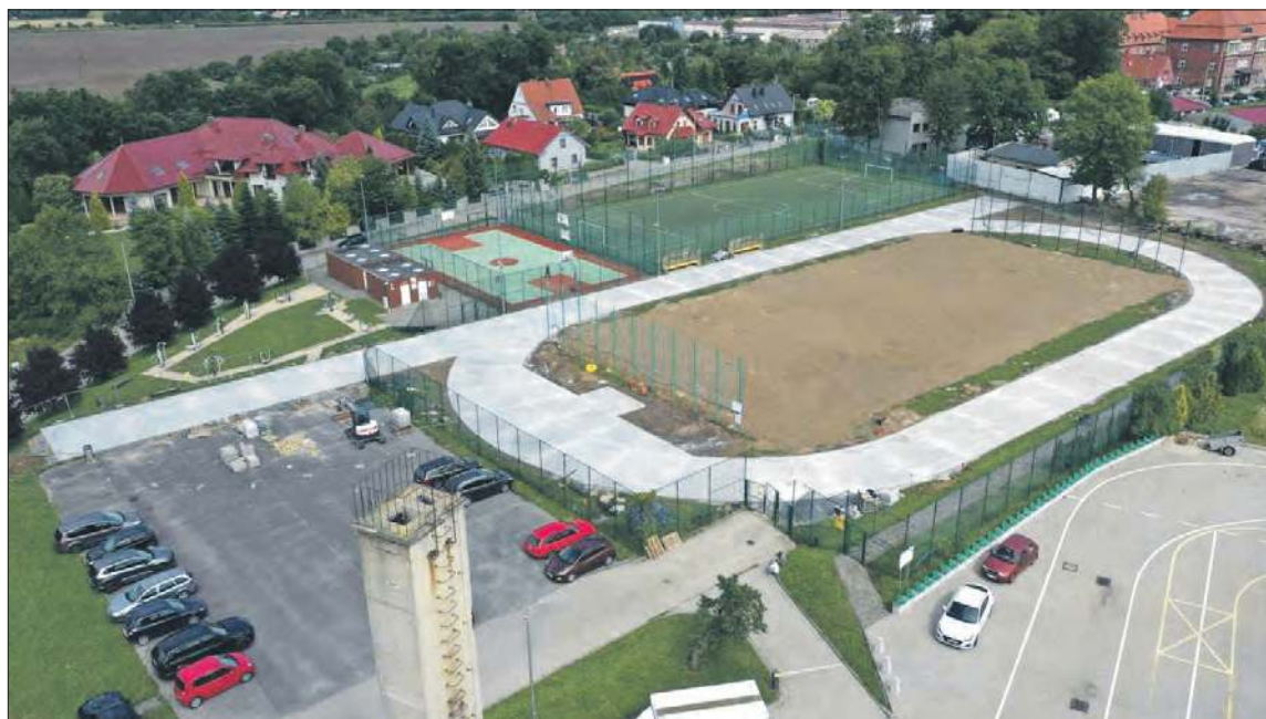
Trwa odnowa i modernizacja kompleksu sportowego przy Zespole Szkół Rolniczych w Prudniku
