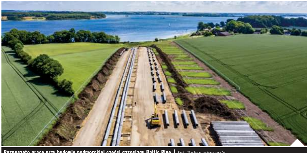
Rozpoczęto prace przy budowie podmorskiej części gazociągu Baltic Pipe | fot. Baltic-pipe.eu/d
