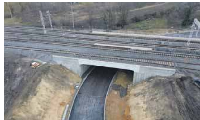
Trwa budowa wiaduktu nad ul. św. Wojciecha w Radzionkowie
