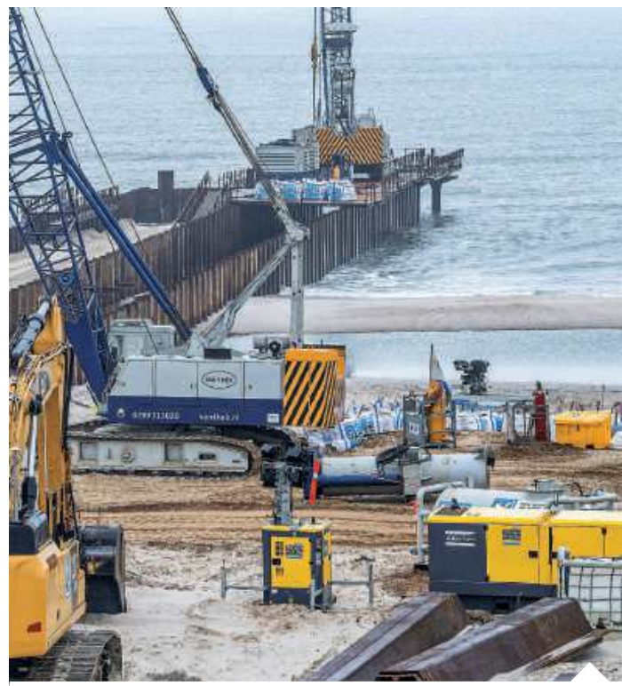
Trwająca na terenie Danii budowa Baltic Pipe została wstrzymana
