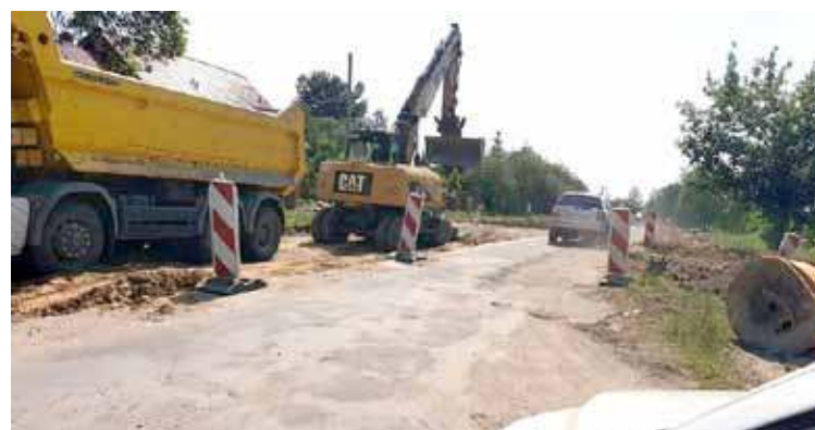
Firma Strabag wykonawca robót przystąpiła do demontażu starej nawierzchni jezdni
