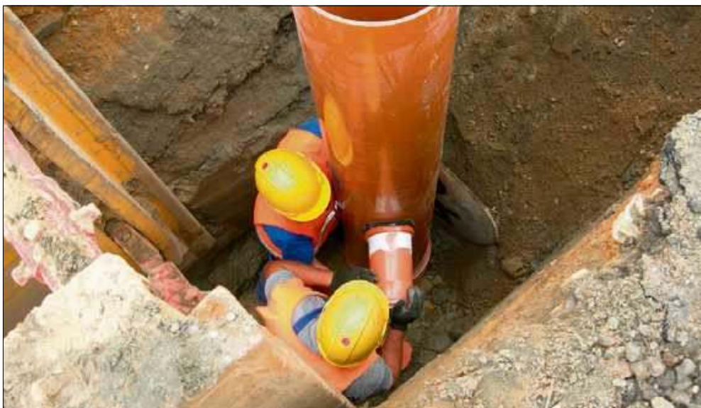
Gmina Strzeleczy stopniowo jest kanalizowana.
