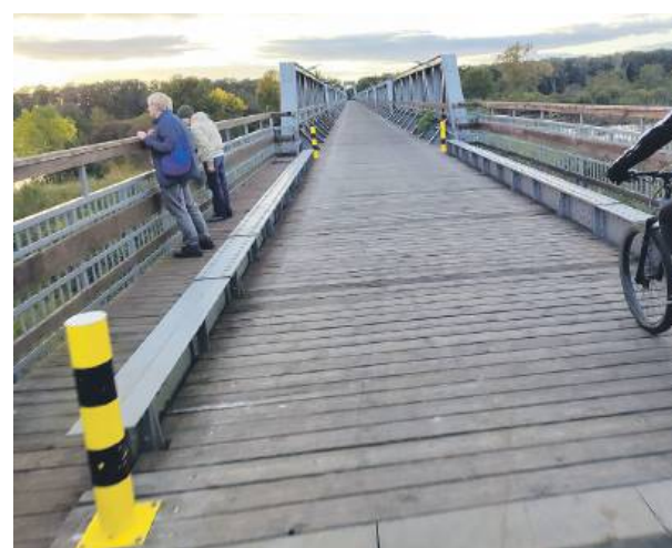
Jednym z najciekawszych miejsc na trasie „Kolej na rower” jest most nad Odrą w Bobrownikach
