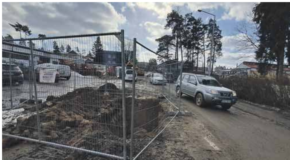
Pierwsze wykopy w powstającej Strefie Aktywności Gospodarczej.
