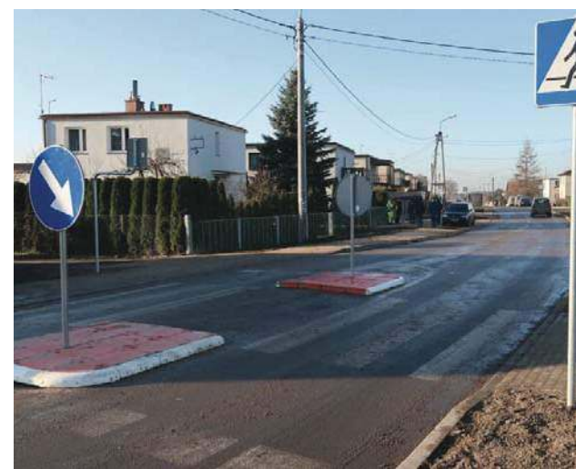
Przebudowa ulicy Nowej w Płońscy
