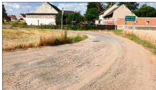
Przebudowa drogi została dofinansowana z budżetu województwa opolskiego.
