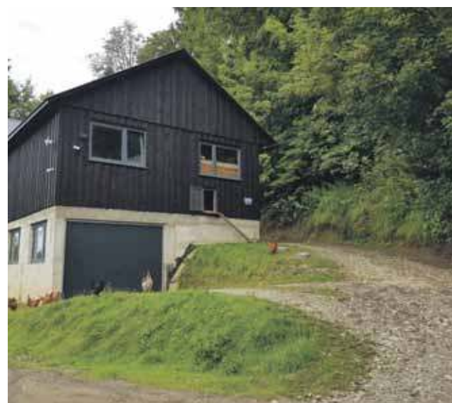
W miejscu drewnianej, parterowej szopy stoi tuż przy zakopiance dwukondygnacyjny „budynek garażowy”.
