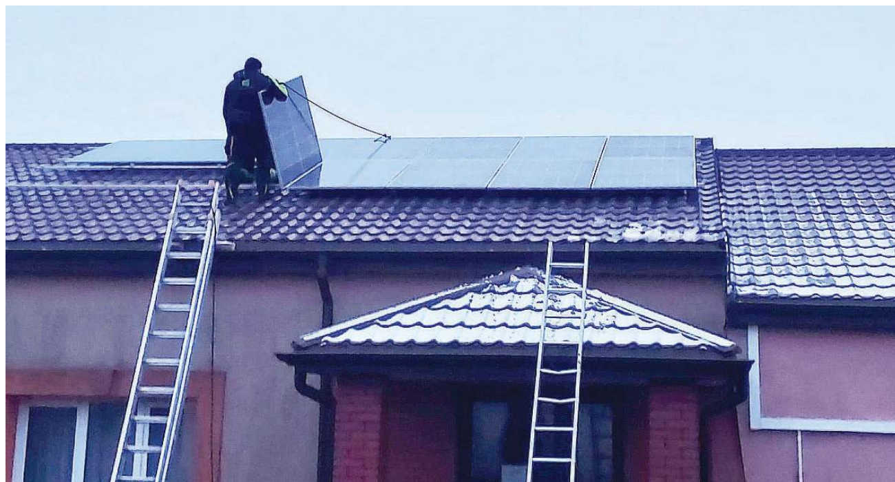
Montaż instalacji fotowoltaicznej na budynku Ochotniczej Straży Pożarnej w Trzcińcu
