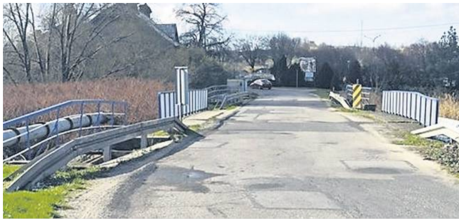
Burmistrz Dorota Pawnuk podpisała umowę na przebudowę 93-metrowego odcinka ul. Brzegowej od skrzyżowania z drogą krajową i pierwszego mostu, patrząc od strony ul. Wojska Polskiego
