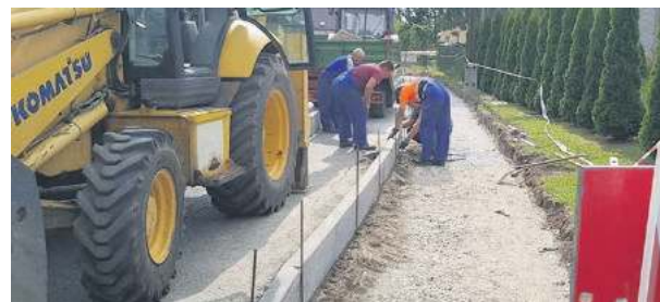
PZD rozpoczęło budowę chodnika w Czerwieńcu
