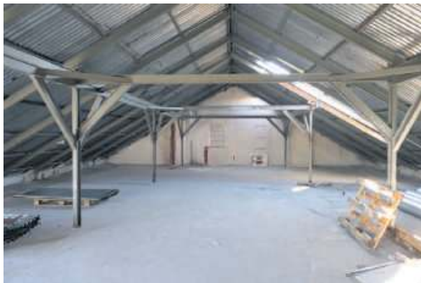
Na poddaszu powstanie ogromna sala widowiskowa. Wcześniej zostanie wymieniony dach, a także usunięte widoczne na zdjęciu metalowe wsporniki
