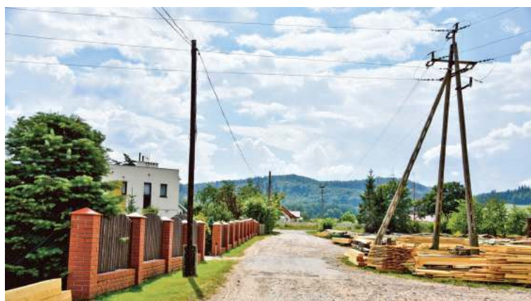
Do końca października planowane jest wykonanie m.in. korytowania dróg i montaż przepustów drogowych | fot. mat. pras./d
