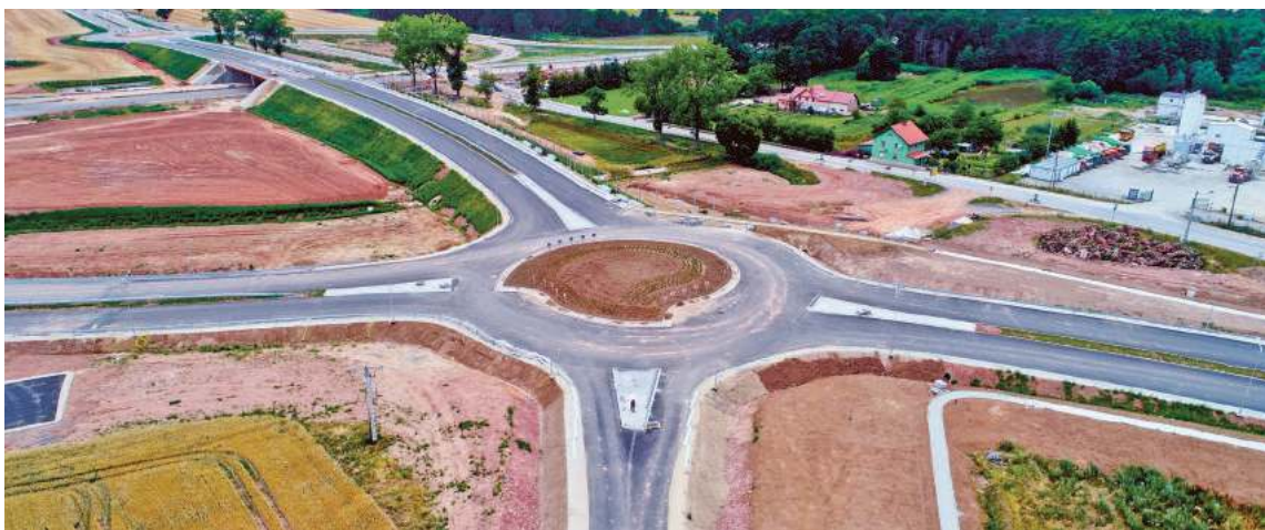
Od piątku droga krajowa DK5 przebiega nad S3 przez wiadukt WD21 relacji Wrocław–Kamienna Góra | fot. GDDKiA/d
