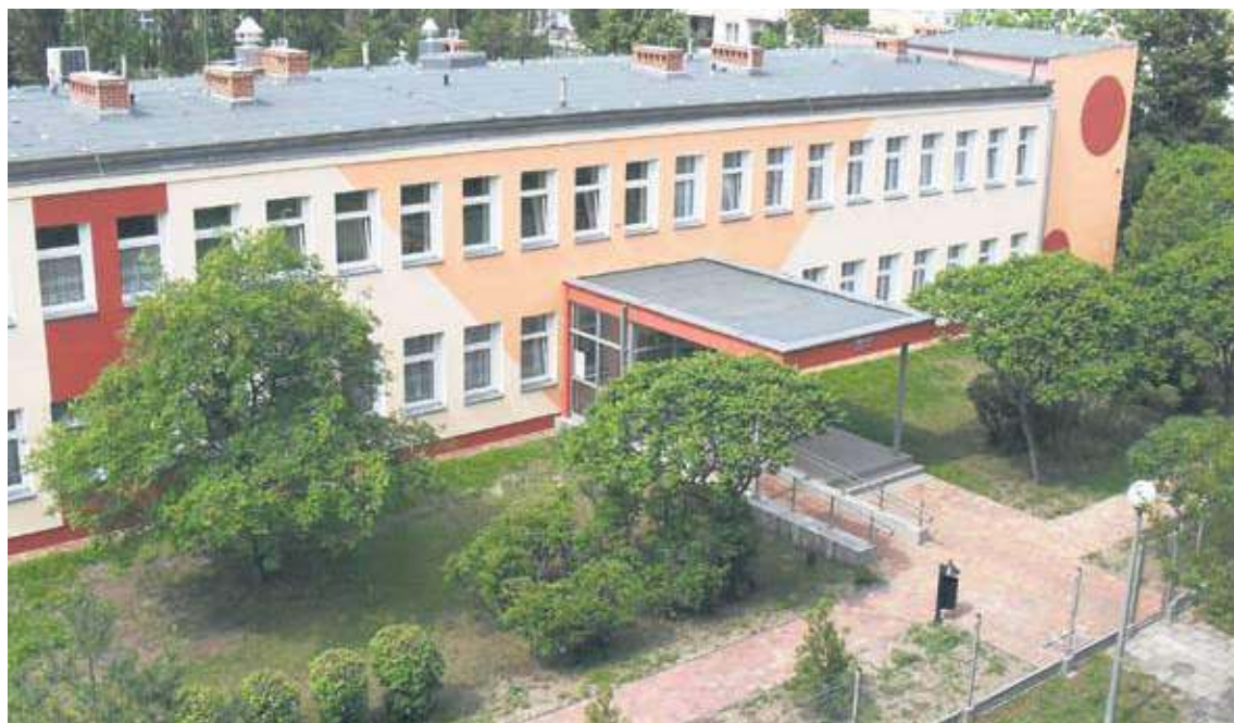
Żłobek będzie rozbudowany do połowy grudnia
