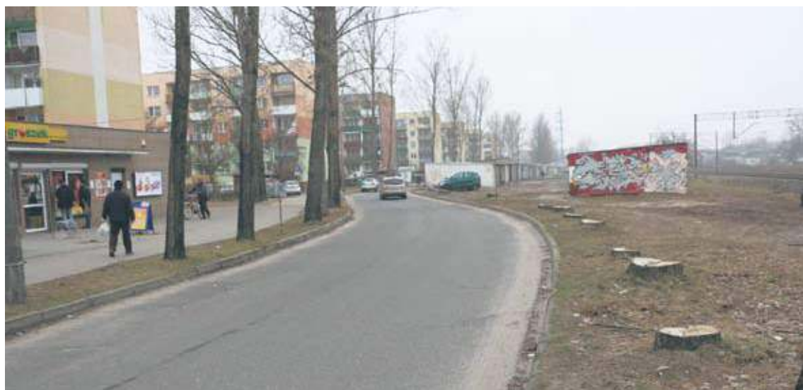
Pierwszym etapem modernizacji będzie całość ulicy Fredry
