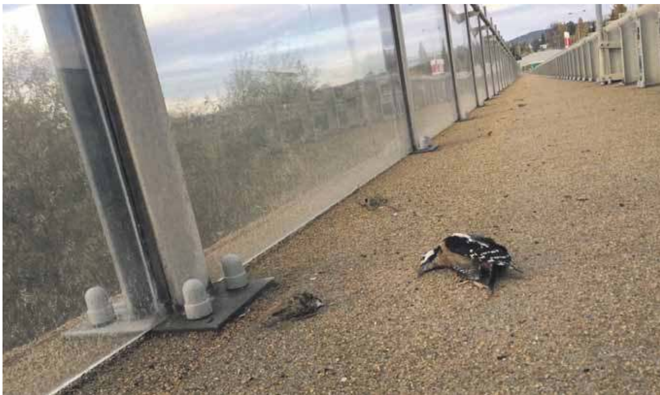
Martwe ptaki na wiadukcie
