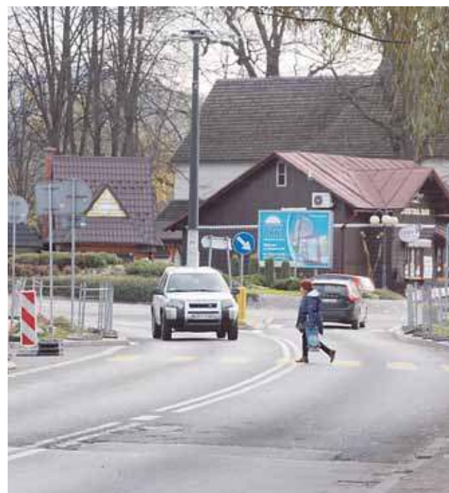
Tak wygląda pilotażowy projekt upłynnienia ruchu na rondzie w Krościenku.
