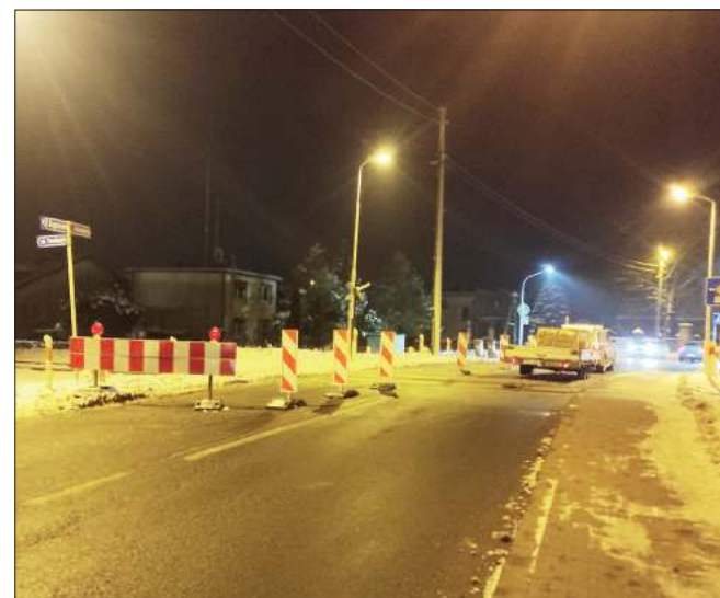
■ Przejazd kolejowy w Studziennej jest przejezdny tylko częściowo. Do 15 grudnia potrwać tu prace remontowe.
