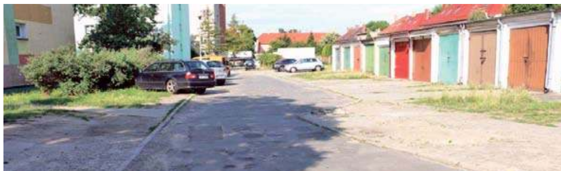
Ta wewnętrzna droga wkrótce powinna doczekać się remontu
