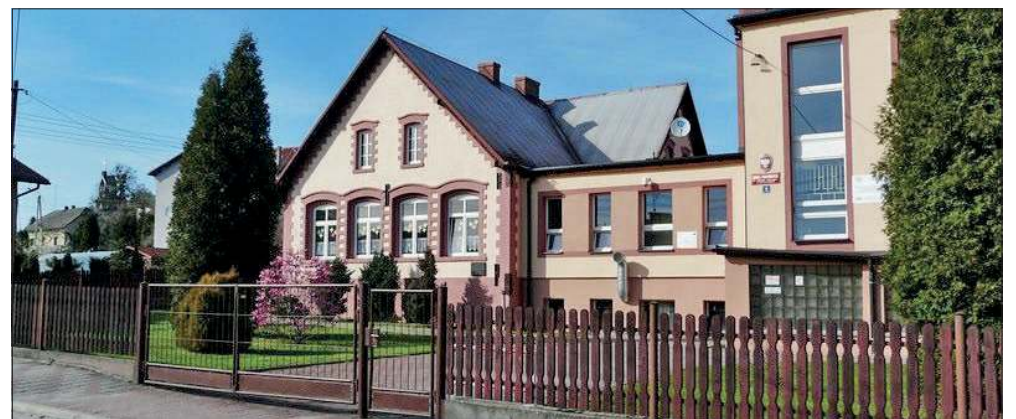
Budynek Szkoły Podstawowej w Krostoszowicach będzie zmodernizowany o dwa oddziały przedszkolne wraz z zabudową pompy ciepła oraz montażem instalacji fotowoltaicznej
