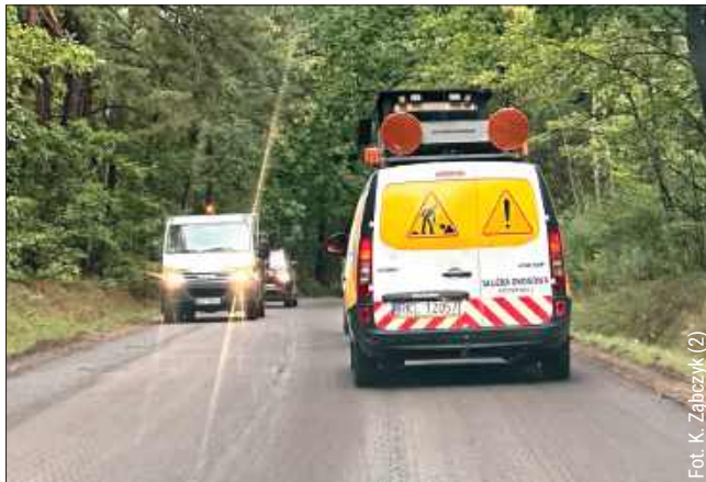
Kilka dni temu drogowcy zrywali asfalt.
