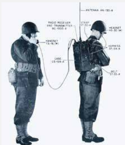
SCR-300 mieściła się w plecaku i umożliwiała ręczne ustawienie częstotliwości FM. W porównaniu z konkurencyjnymi urządzeniami, które były tak duże, że transportowano je przy użyciu czołgów, wynalazek Polaka był wręcz niewiarygodnie lekki. FOT. WIKIPEDIA
