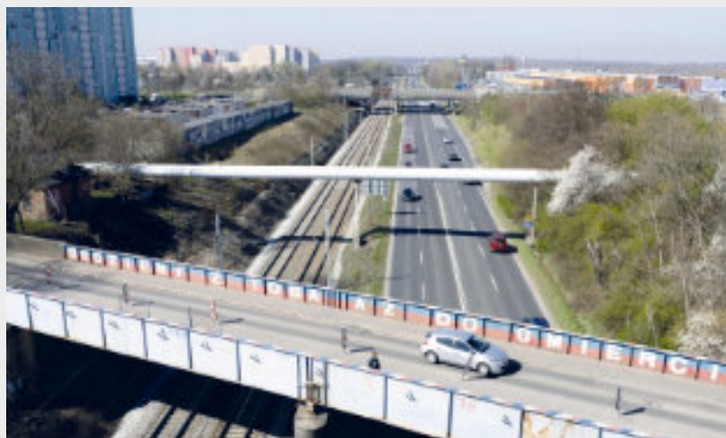
► Objęty przebudowę wiadukt Fot. UM Zabrze
