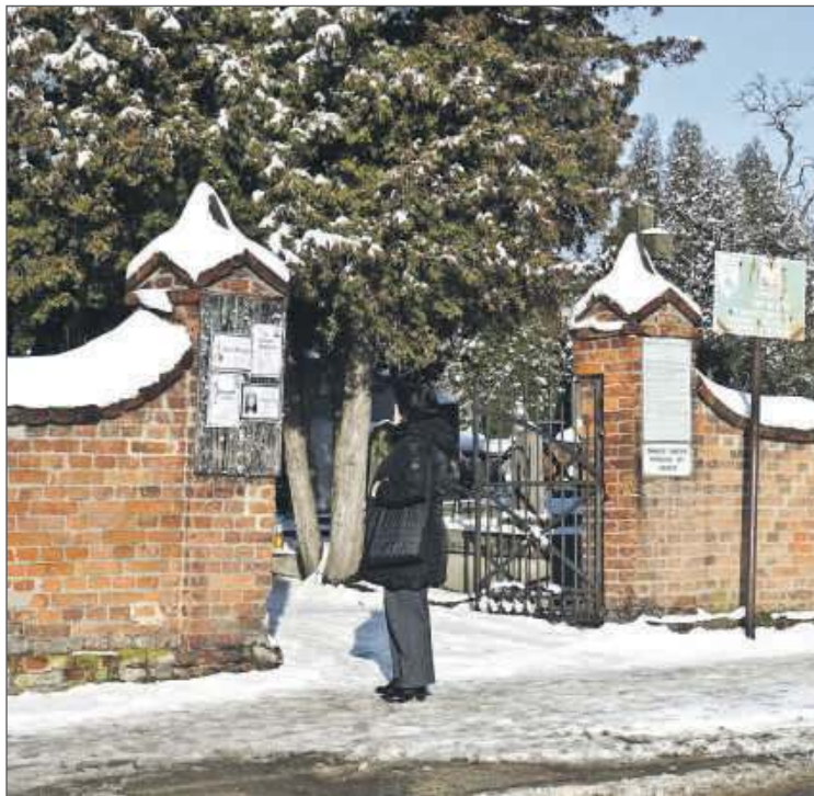
Remont ogrodzenia może kosztować nawet 2,5 mln zł.
