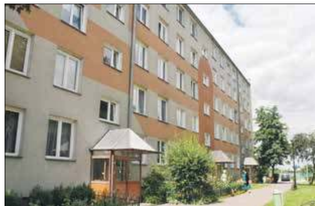
Blok przy ul. Sidorskiej 12 wkrótce będzie ocieplany, co może spowodować zniszczenie roślin przed nim rosnących
