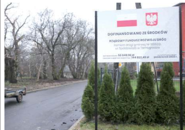
Ulica Spółdzielcza w Tarnogrodzie już po remoncie
