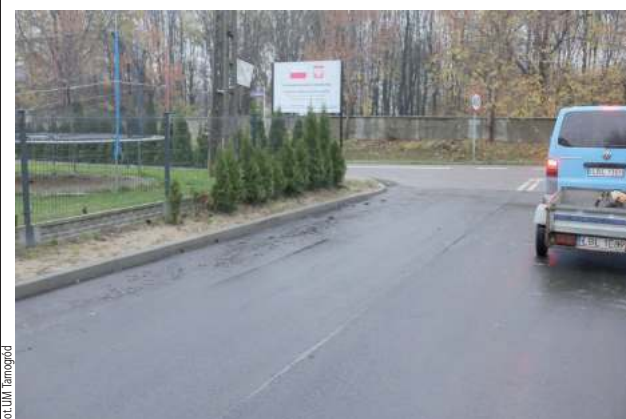
Ulica Spółdzielcza w Tarnogrodzie już po remoncie
