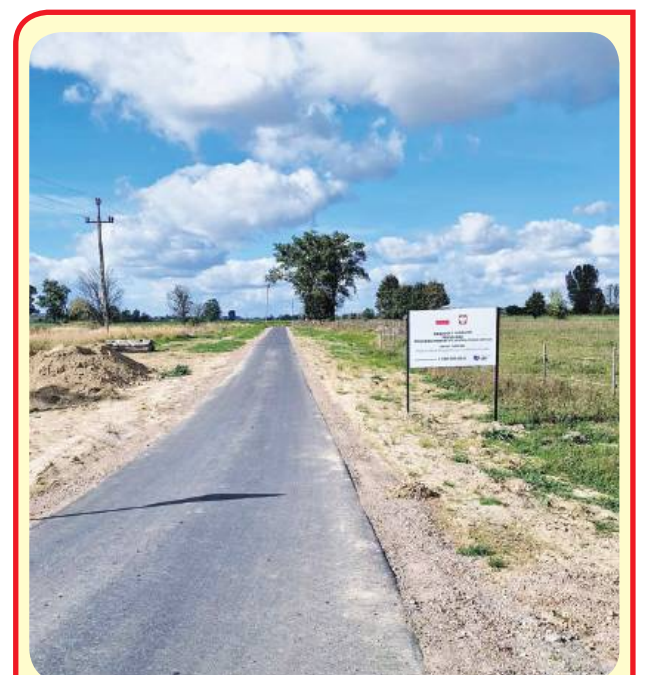
Nowa droga Turobin – Olszanka – Tarnawa Mała. Wybudowana ze środków Nowego Ładu. Będzie służyć mieszkańcom jako droga, którą poruszają się samochody, jako ścieżka rowerowa, ciąg pieszo-spacerowy oraz dojazd rolników do pól.
