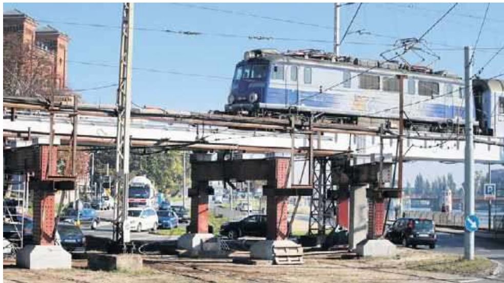
Pociągi kursują już po wyremontowanej części wiaduktu kolejowego nad ulicą Kolumba. Zakończenie prac planowane jest do końca 2021 roku
