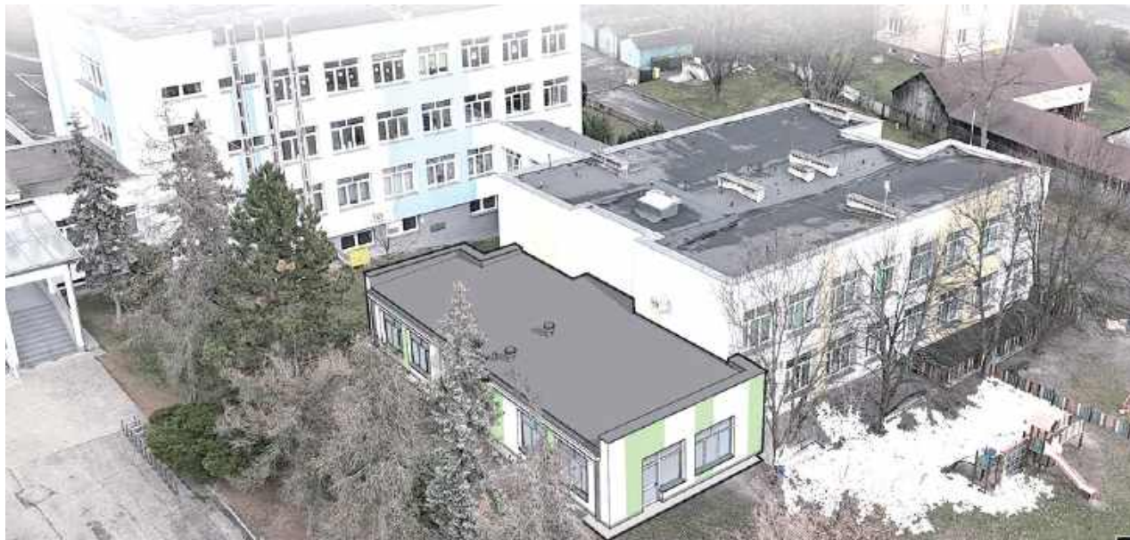
Do obecnego obiektu dobudowany zostanie jednokondygnacyjny budynek, który pomieści 24-osobową grupę dzieci
